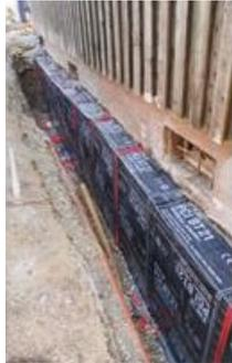
Da der Graben für die neuen Abwasserrohre entlang der Südseite des Gebäudes verlaufen wird, wurde beschlossen, die Außenwände in diesem Zuge mit abzudichten. Die Gesamtkosten für die Sanierung des Kanals belaufen sich auf ca. 60.000 Euro. Dankenswerterweise haben wir einen Zuschuss vom OKR Württemberg und ottopermille erhalten, so dass wir mit den Baumaßnahmen beginnen konnten.
